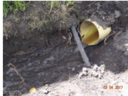
Fotografía 21. Tuberías domiciliarias sanitarias informales que descargan aguas residuales en canales abiertos informalmente. Fuente: SER-SDA, 2017.
