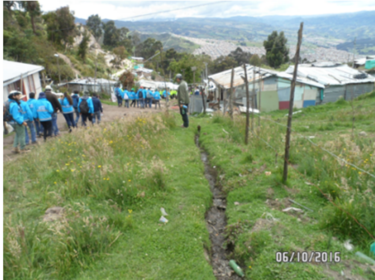
Fotografía 5. Se observan zonas inestables con procesos activos de remoción de materiales utilizados en la construcción de las cimentaciones de las viviendas. Esta situación es de alto riesgo para la comunidad que habita el sector. Fuente: SDA-SER.
