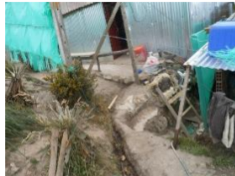
Fotografía 29. Descarga de aguas residuales al suelo y canales en tierra de las viviendas ubicadas en el sector suroccidental del área – San German (24/10/2017). Fuente: SER-SDA, 2017.
