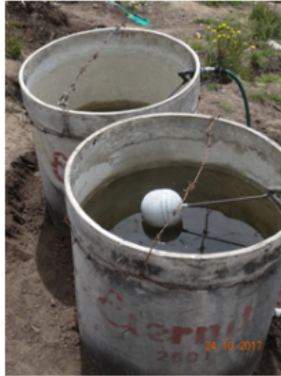
Fotografía 116. Adecuaciones de tanques de almacenamiento de agua generando proliferación de vectores y uso inadecuado del agua. Fuente: SDA-SER, Octubre de 2017. (...)
