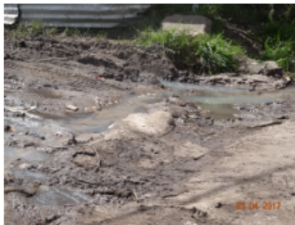
Fotografía 22. Descargas directas a cielo abierto de aguas residuales de las viviendas informales en suelo y drenaje afluente de la Quebrada Santa Librada. Fuente: SER-SDA, 2017.
