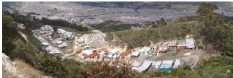
Imagen 11. octubre de 2017. Estado actual de la zona. Fuente: SDA-SER, 2017.
