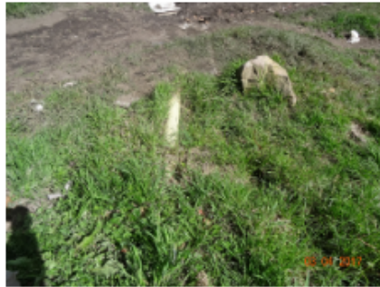
Fotografía 20. Tuberías domiciliarias sanitarias informales que descargan aguas residuales en canales abiertos informalmente. Fuente: SER-SDA, 2017.
