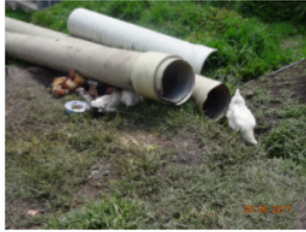
Fotografía 99: Manejo inadecuado de materiales de construcción afectando coberturas vegetales y suelos del área protegida del PEDMEN. Fuente: SDA-SER, CT 01444 de 2017.
