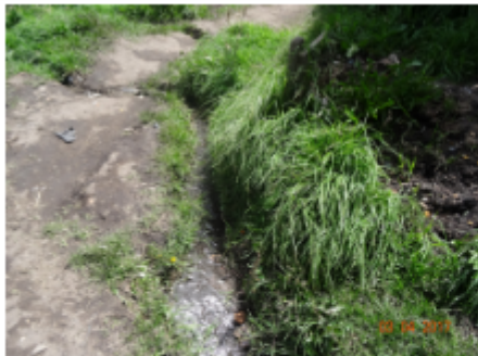
Fotografía 16. Canales construidos de manera informal para la conducción de aguas pluviales y sanitarias de las viviendas informales emplazadas. Nótese el transporte de aguas residuales en un día sin precipitación. Fuente: SER-SDA, 2017.
