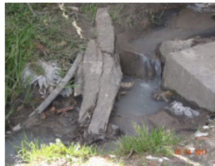
Fotografía 23. Descargas directas a cielo abierto de aguas residuales de las viviendas informales en suelo y drenaje afluente de la Quebrada Santa Librada. Fuente: SER-SDA, 2017.
