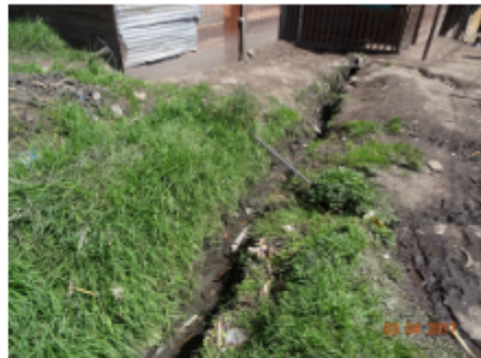
Fotografía 17. Canales construidos de manera informal para la conducción de aguas pluviales y sanitarias de las viviendas informales emplazadas. Nótese el transporte de aguas residuales en un día sin precipitación. Fuente: SER-SDA, 2017.
