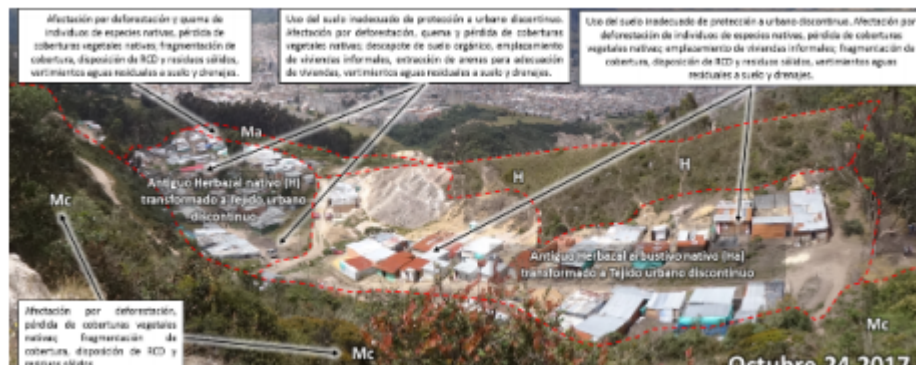
Imagen 24: AUMENTO Y CONSOLIDACIÓN DE PROCESOS DE EMPLAZAMIENTO DE VIVIENDAS INFORMALES Y DE LA AFECTACIÓN A COBERTURAS PARA EL PERIODO OCTUBRE DE 2017; se observa la consolidación de viviendas informales en diferentes materiales constructivos, algunas de estas viviendas se consolidan con materiales constructivos y mampostería en uno y dos niveles; además se consolida el Tejido urbano discontinuo sobre el 100% del área correspondiente a Herbazales arbustivos nativos (Ha) y Herbazales nativos (H); se mantiene la afectación antrópica en las demás coberturas.
