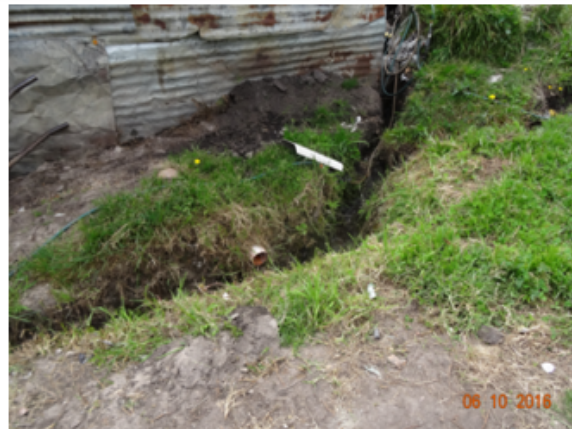
Fotografía 8. Octubre de 2016. Zanjas para evacuación de aguas residuales. Fuente: SDA-SER.
